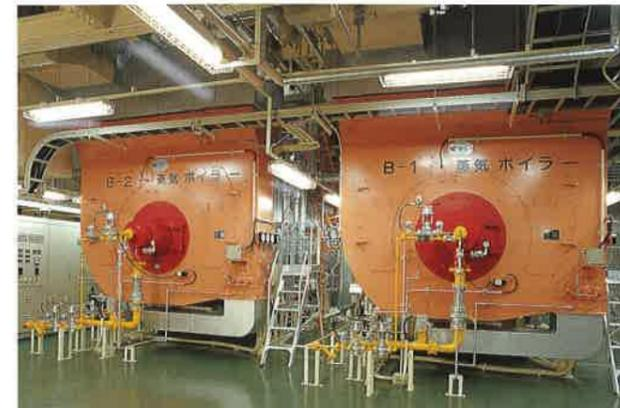
炉筒煙管式蒸気ボイラ
