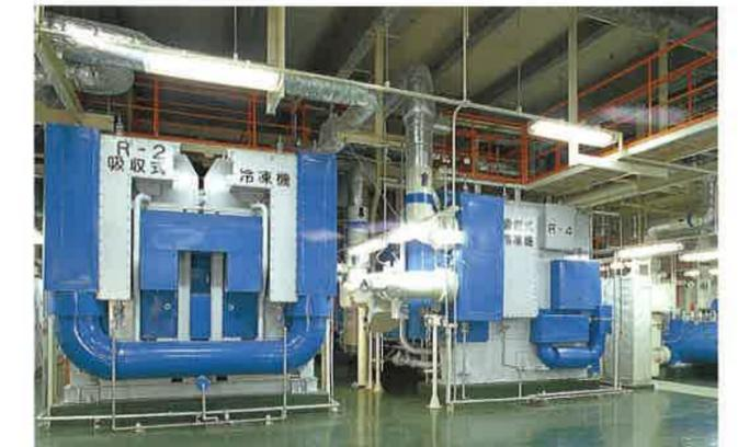
蒸気吸収冷凍機
